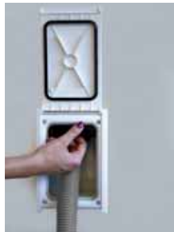
3 – blokkolja a kihúzott csövet (ezzel beindítja az elszívást)
