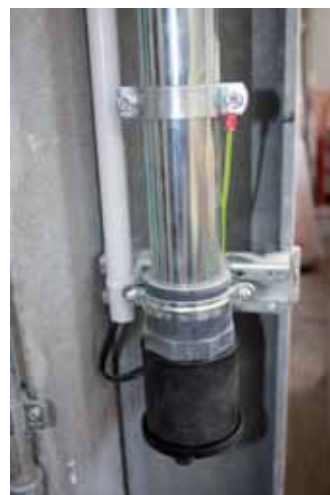
Presa aspirante antistatica con collegamento di terra.
